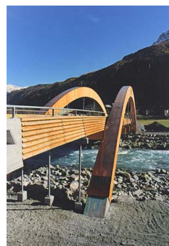
Eine Reihe innovativer Details beim BSH-Bogentragwerk wie auch bei der Fahrbahnplatte zeichnet die offene Strassenbrücke über den Inn bei San Nicl  aus.
