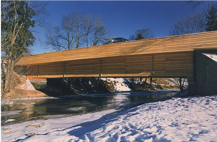
Die Strassenbrücke (90 t) über die Thur bei Nesslau besteht einzig aus gesägtem Massivholz (160 m 3 ), das kompakt verbaut wurde.
