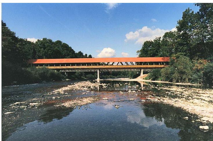
Die Altermer Thurbrücke bei Andelfingen ist mit 108 m das längste Holzbauwerk (P. Grunder, 1992), das ins Schweizer Strassennetz eingebunden ist.
