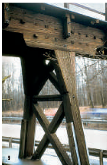
9 Diese 1938 erstellte (und inzwischen abgerissene) Holzbrücke bei Pforzheim erreichte durch einen konstruktiven Holzschutz (Asphaltbelag) eine lange Lebensdauer bei gleichzeitig geringem Unterhalt
