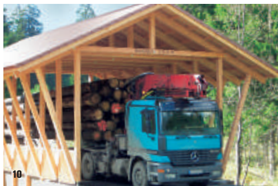
10 Die erste deutsche Schwerlastbrücke (60 t) in Holzbauweise führt über den niedersächsischen Brunnenbach. Der Bauherr erwartet von der Brücke eine Nutzungsdauer von 100 Jahren
