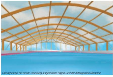
dungen sind mit Knotenplatten und Stiften in der bewährten und sicheren BSB-Technologie ausgeführt. Die Membran spannt über 9,25 m mit einem Stich in Feldmitte von ca. 500 mm. An der Traufe wird diese mit einer Vorspannkraft von ca. 2 kN/m «eingehängt».
