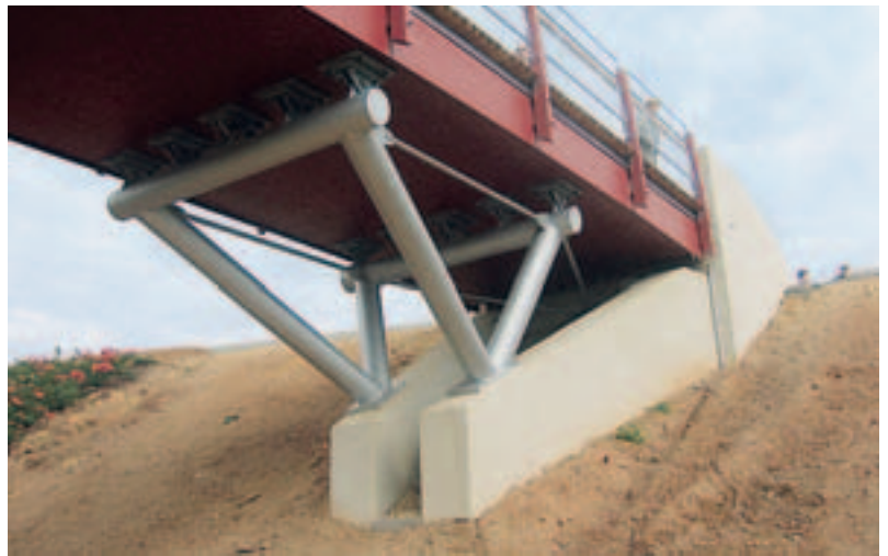
Das Widerlager der fertiggestellten Brücke
