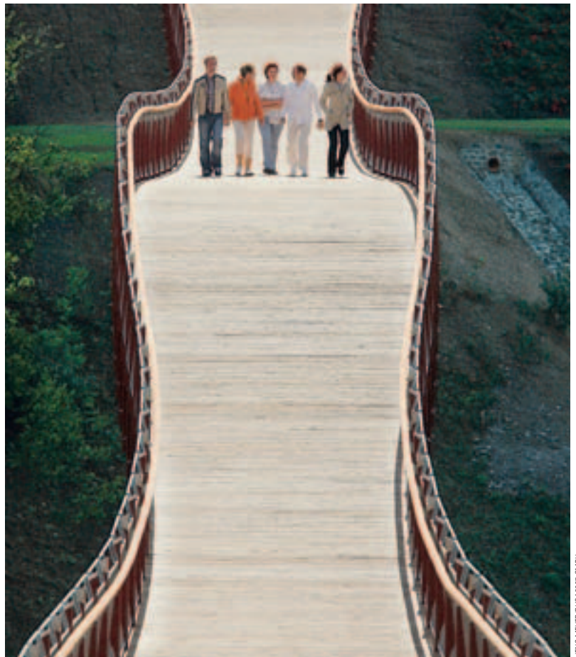
Die Breite der Brücke namens „Drachenschwanz“ variiert zwischen 2,50 m und 3,80 m
