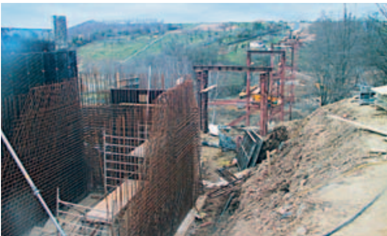
Der Brückenverlauf ist bei der Montage der Hilfsstützen und der Verschalung des Widerlagers bereits zu erkennen
