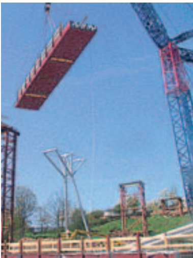
Ein Brückenbauteil schwebt ein. Da die Spannbandkonstruktion jetzt noch nicht funktioniert, müssen vorerst Hilfsstützen die Lasten abtragen
